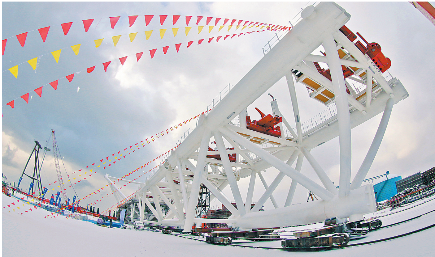
日前,由烟台打捞局船厂承建的3000米深水铺管托架建造项目顺利竣工。该托架是实现3000米深水铺管功能的关键装备,主框架是横剖面呈倒三角形的管式桁架结构,总长110.2m,最宽处39.2m,总重约1428吨,全部由高强度板卷管和高强度无缝钢管组对焊接而成。该项目的建成投用,将显著增强中国深水铺管能力,对实现国家海洋强国战略目标意义影响深远。
