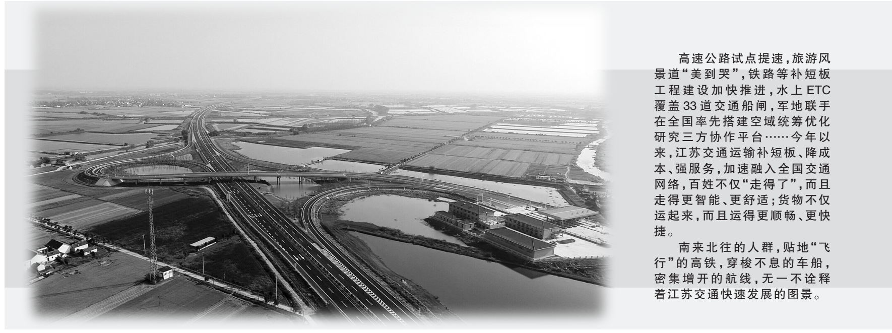
阜兴泰高速公路。江苏省交通运输厅 供图
