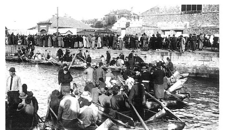
十九世纪码头驳运旅客上岸。烟台港档案馆供图
