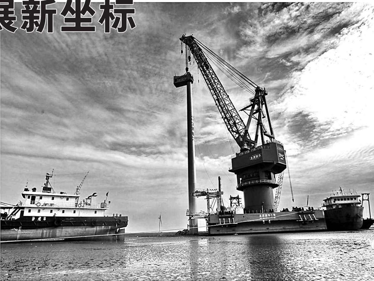
海上风电安装现场。
