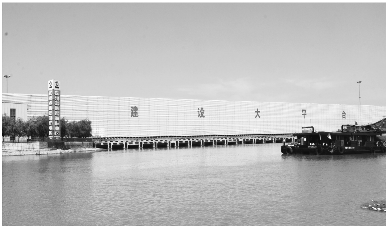
顺堤河作业区防风抑尘网。王畅 摄
