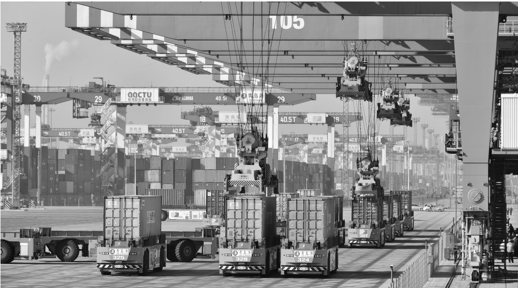
青岛港集装箱码头作业现场。
