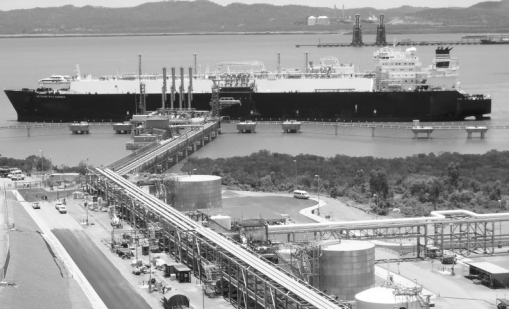
△中海油和 BG 集团柯蒂斯项目外输首船 LNG。
