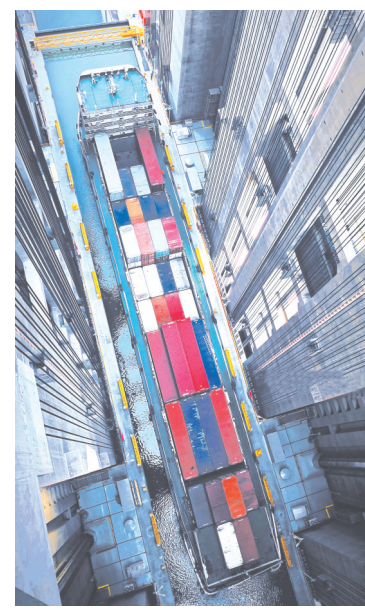
▲船舶过闸。殷黎 摄
