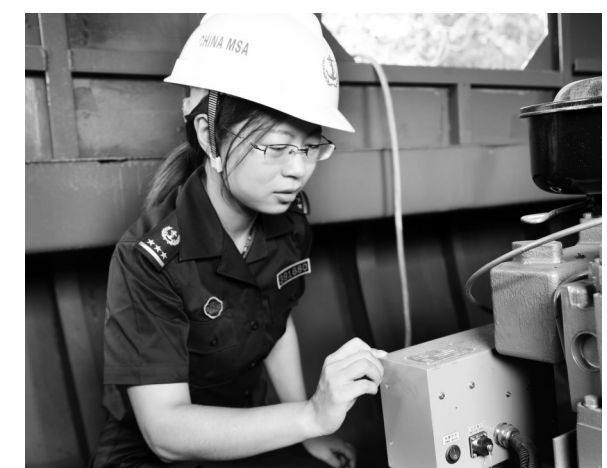
郑咪咪正在进行电气检查
