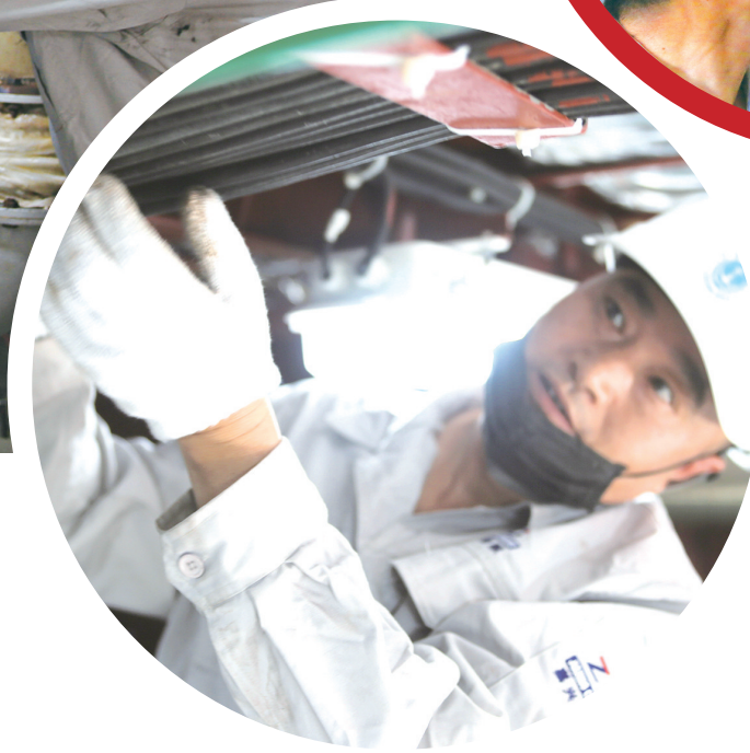
▲杨洪明检验艇舱内部线路。
