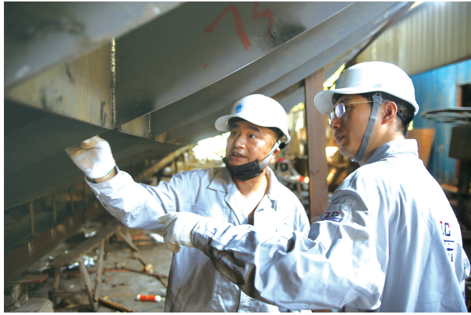
9时30分 廖正勇、杨洪明检验船体焊缝质量。
