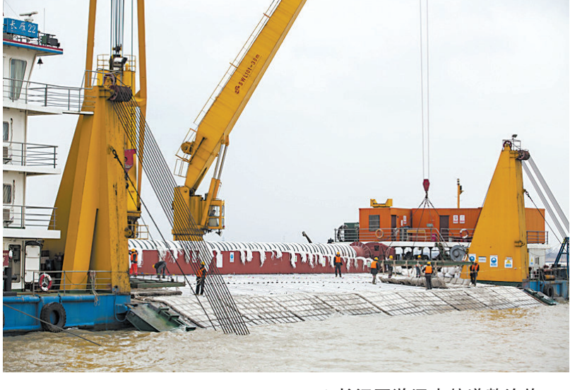
▲长江下游深水航道整治施工。
