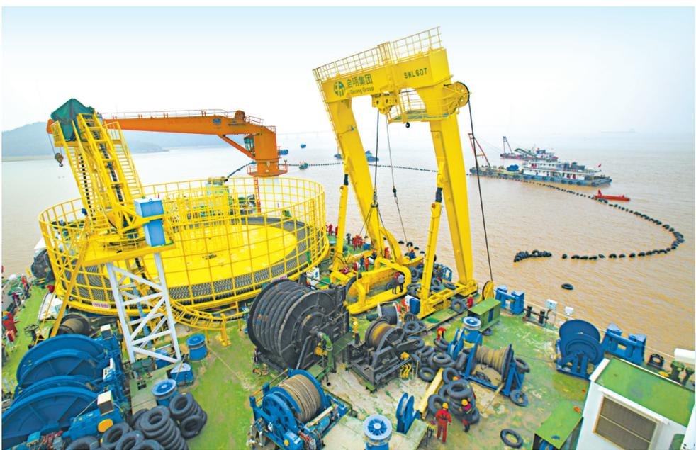
11月20日,经过连续150个小时的海上铺设施工作业,世界首条500千伏交联聚乙烯海底电缆登陆舟山市金塘大鵬岛海岸,连接到舟山500千伏联网输电工程大鵬岛终端桩基。该海缆由目前国内最新型海底电缆施工船“启帆9号”承接铺设,这也是“启帆9号”的首次作业。 姚峰摄
