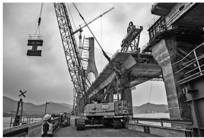
12月12日，宁波舟山港主通道富翅门大桥A标引桥桥梁完成顶推施工。据了解，如此大跨度深海域超混混凝土步履式顶推在国内施工尚属首次。此次顶推施工标志着富翅门大桥A标又一重要节点完成。上图为顶推施工现场。
