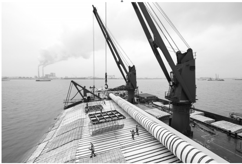
▲长江下游深水航道整治施工。
