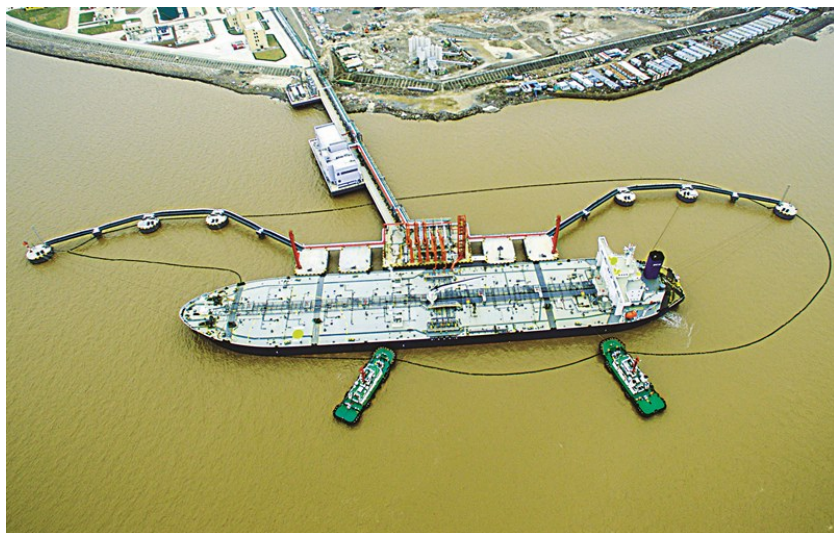
2018年12月30日,载运9.69万吨原油的利比亚籍船舶“PETROPAVLOVSK”轮在宁波舟山港外岛30万吨级油品码头进行卸载作业,标志着该码头正式启用,这也是目前舟山对外轮开放的第4座30万吨级码头泊位。姚峰 摄
