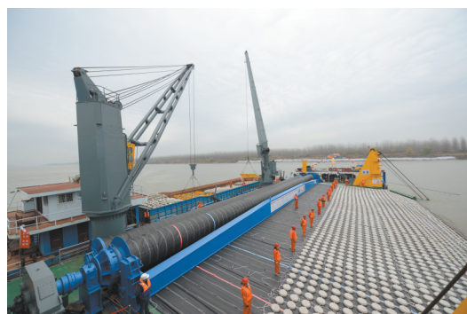
“645”工程武汉至安庆段开工。
