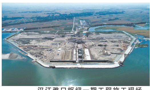
汉江雅口枢纽一期工程施工现场。
