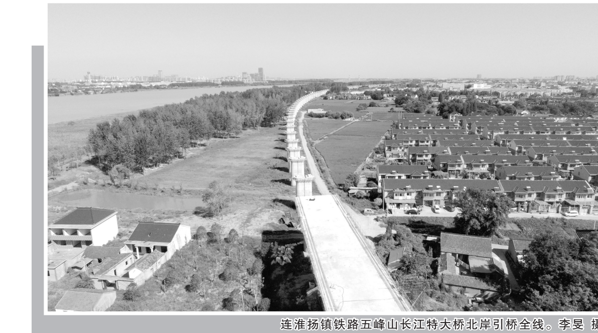
连淮扬镇铁路五峰山长江特大桥北岸引桥全线。李曼 摄
