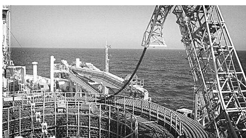
光缆船铺缆系统。 本文图片由谢予提供
