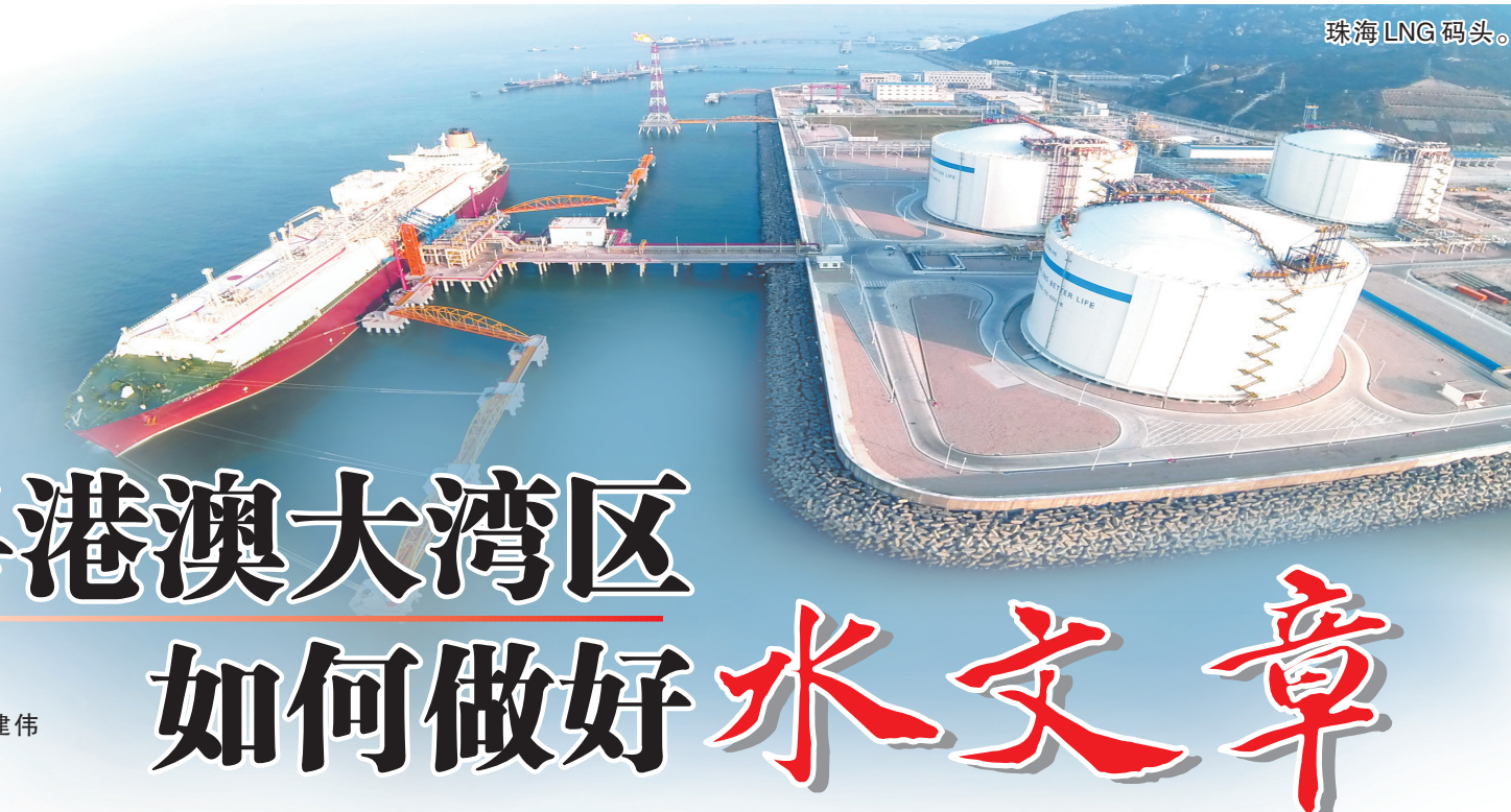
珠海LNG码头。
