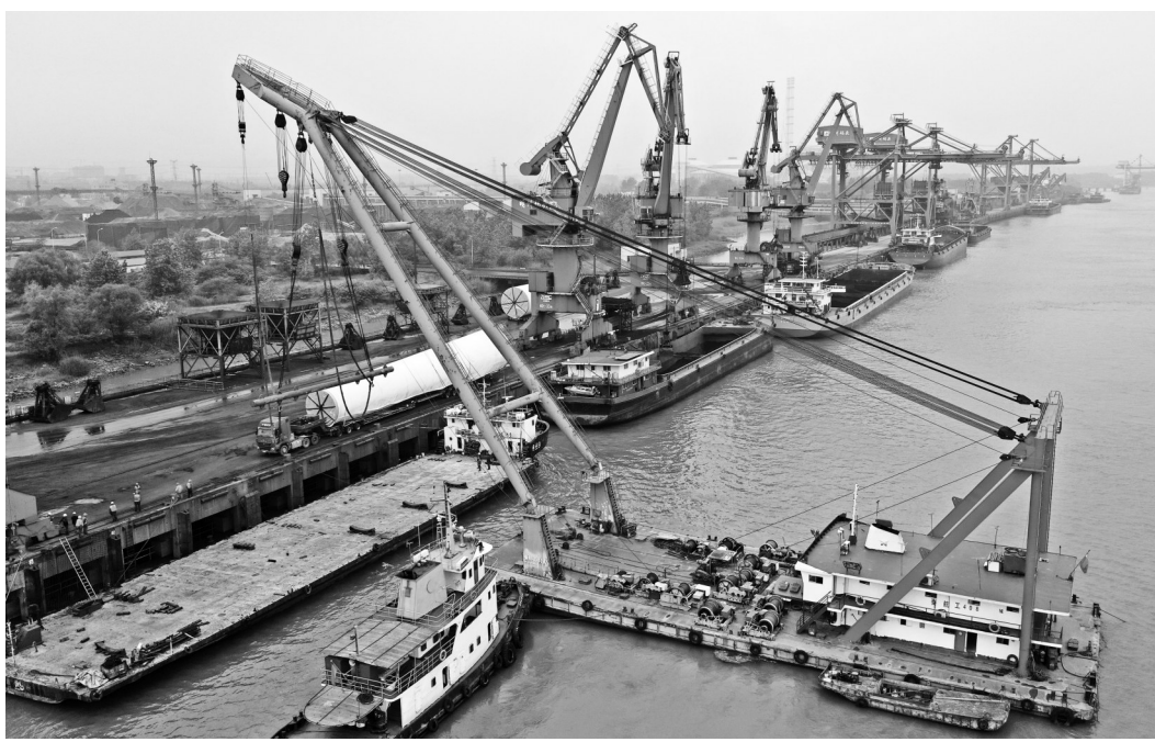
4月23日晚,中建安装集团中建五洲公司制造的首个海上风电塔筒从南京港吊装。这是该公司为上海临港海上风电项目制造的首个海上风电塔筒,装机容量6MW,总重400多吨,高95米。 纪昕昕 摄
