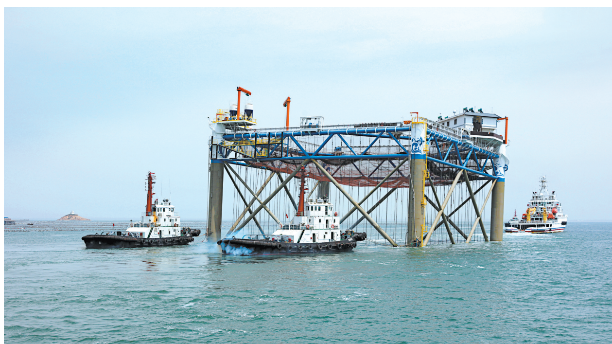
5月8日,“长鲸一号”深水智能网箱在烟台海事局护航下,被拖带出烟台中集来福士码头,前往长岛海域。该网箱长宽均为66米,有效养殖水体为6.4万立方米,相当于100个普通网箱,能通过大数据技术实时反馈海洋水文信息和监测数据,是国内首个通过美国船级社检验的网箱。 杨柳 周洪洋 摄
