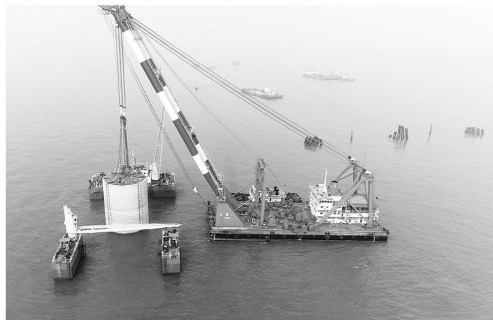
近日,在青岛海事局护航下,重2933吨、高31米、直径15米的沉箱“乘坐”半潜船经过5个小时的漫长“旅行”,成功从沉箱预制场到达青岛董家口港区30万吨级原油码头二期工程指定位置,整个航行路程7海里。此次拖带的沉箱是董家口原油码头二期工程中14个沉箱中的第一个,青岛董家口海事处筹备组采取多项措施加强监管,保证此次拖带作业的顺利进行和其他船舶进出港安全。杨柳 王赛 王晓宁 摄
