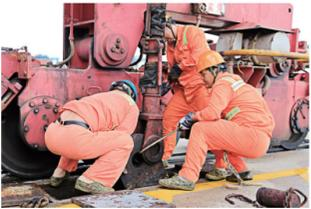
码头工人利用地锚固定吊吊等大型机械设备。 林国平 摄
