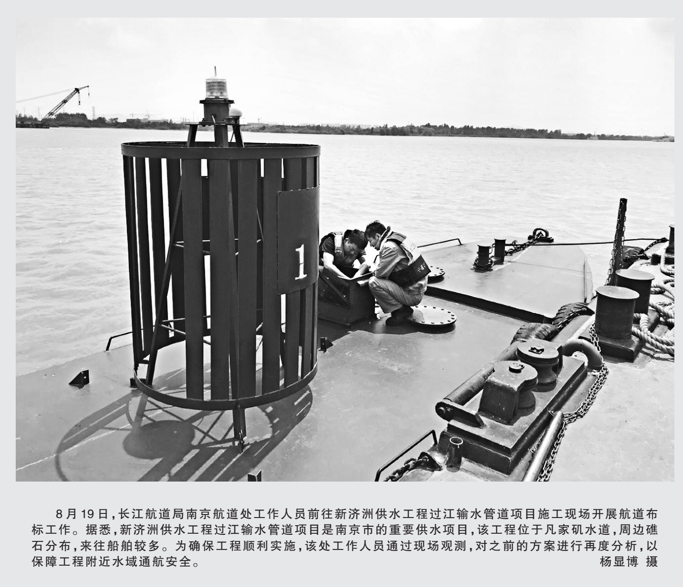
8月19日，长江航道局南京航道处工作人员前往新洲供水工程过江输水管道项目施工现场开展航道布标工作。据悉，新洲供水工程过江输水管道项目是南京市的重要供水项目，该工程位于几家矶水道，周边礁石分布，来往船舶较多。为确保工程顺利实施，该处工作人员通过现场观测，对之前的方案进行再度分析，以保障工程附近水域通航安全。 杨显博 摄
