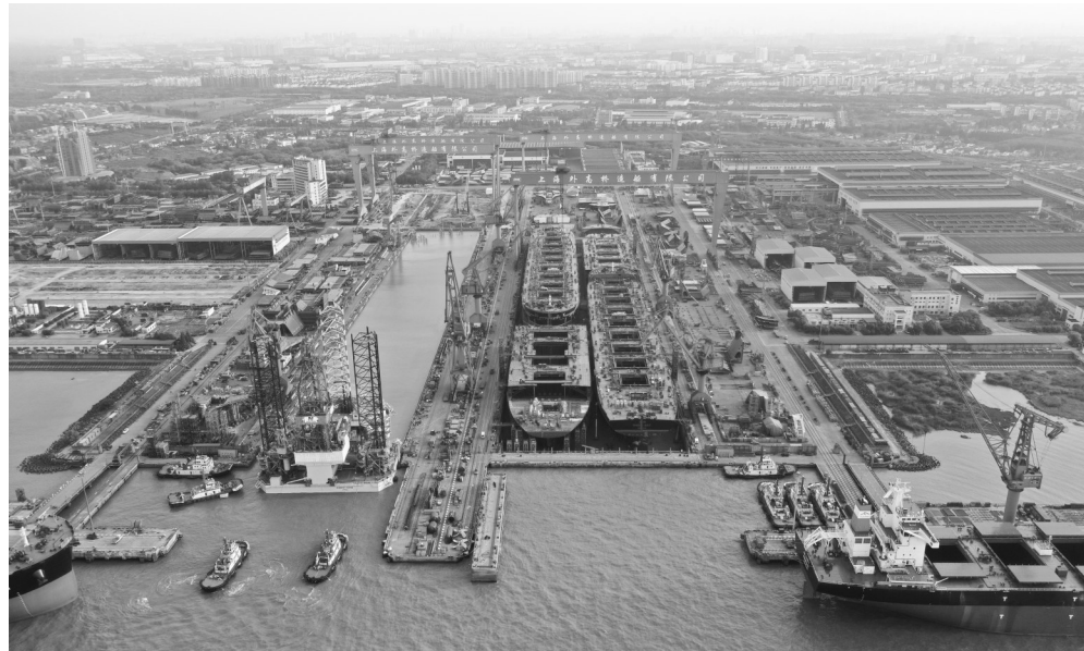
外高桥造船厂。王胤 摄
