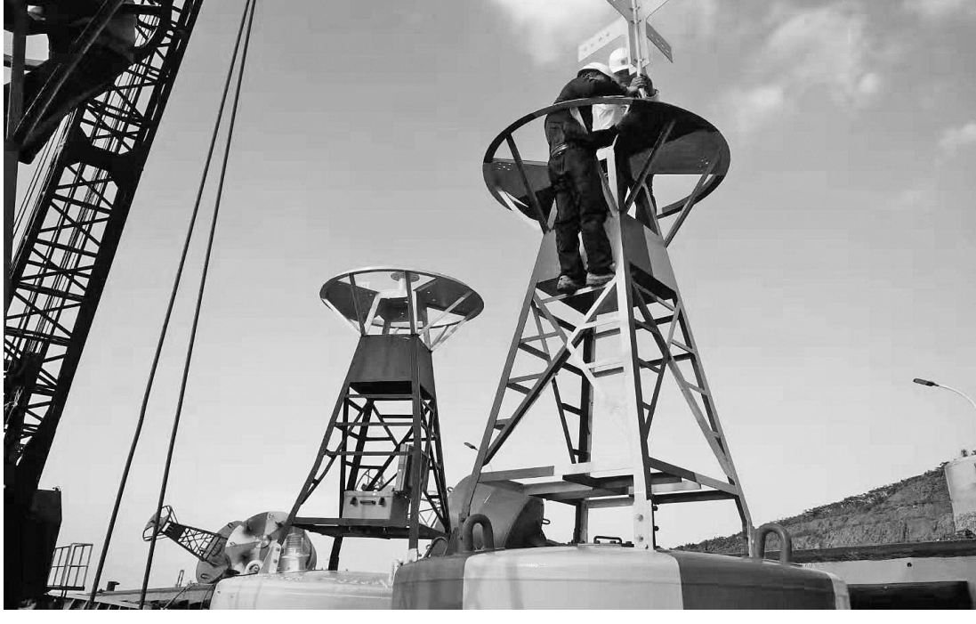
日前，东海航海保障中心宁波航标处6条巡检船舶巡检航标1000余座，发现台风造成的太阳能板损坏、浮筒顶标损坏、灯器损坏、航标漂移等故障航标33处，已全部修复，为舟山地区风力发电、跨海大桥等多个项目的几十条施工船舶的顺利施工提供了保障。 管登红 李金星 摄
