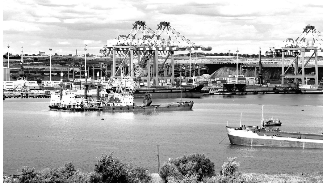
△乌克兰南方港粮食码头工程。天航局供图
