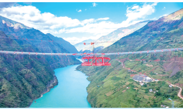
近日，世界最大跨度山区悬索桥——金沙江大桥跨中梁段吊装完成。这是由中交二航局第二工程有限公司承建标段吊装完成的首根钢桁梁。据悉，大桥有望在2020年春节前合龙。
