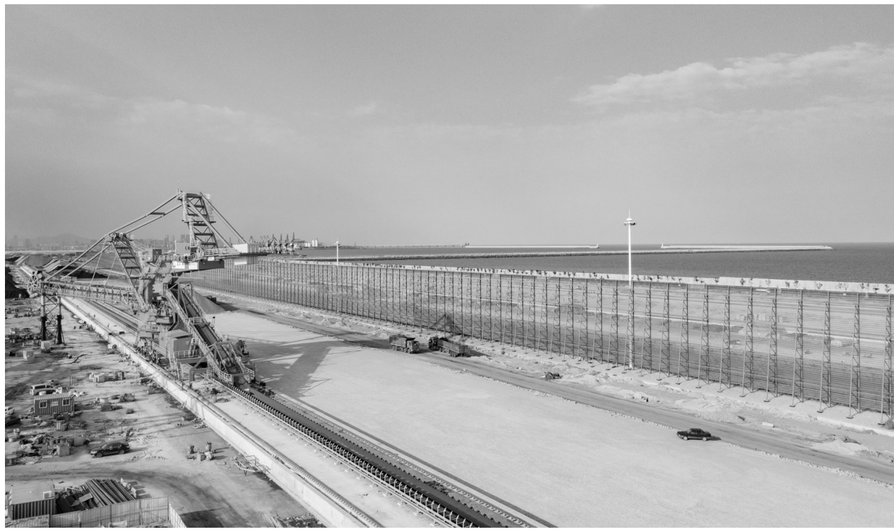
建设中的日照港东煤南移工程。刘勇 徐一杰 摄
