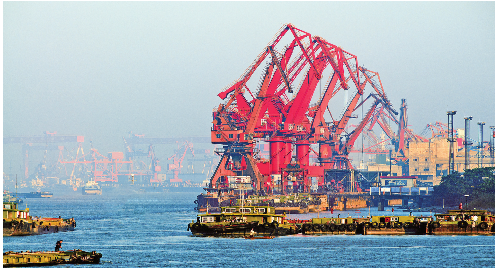
扬中港吊装码头。
