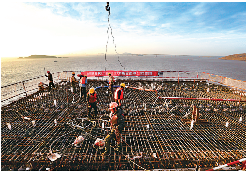
1月6日傍晚，中交二航局的建桥工人正在为浙江交通集团舟岱大桥北通航孔桥BT3主墩左幅0号块进行混凝土浇筑施工。据介绍，舟岱大桥北通航孔桥主墩0号块为国内最高变截面预应力混凝土0号块，当天浇筑的是主墩4个0号块中的最后一个，高13.3米、长17.4米、底部宽5.5米、顶部宽12.55米。
