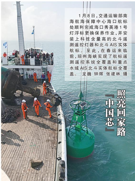
1月8日,交通运输部南海航海保障中心海口航标处顺利完成海口秀英港1号灯浮标更换保养作业,并安装上科技含量高的北斗遥测遥控灯器和北斗AIS实体航标。至此,在春运来临前,琼州海峡实现了航标遥测遥控系统全覆盖和重点水域AIS北斗实体航标全覆盖。龙巍 钟辉 张建新 摄
