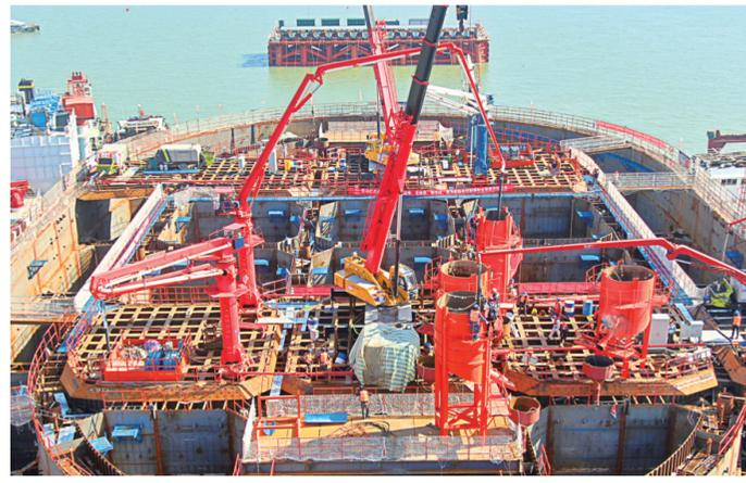
按照计划,大桥沉井年内将最终下沉至设计深度,期间,现场将进行多次夹壁混凝土浇筑、水上接高和取土下
