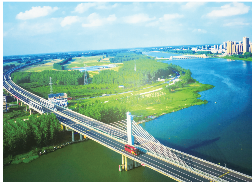
五河西坝口大桥。
