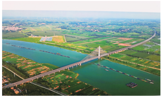
五河淮河公路桥。
