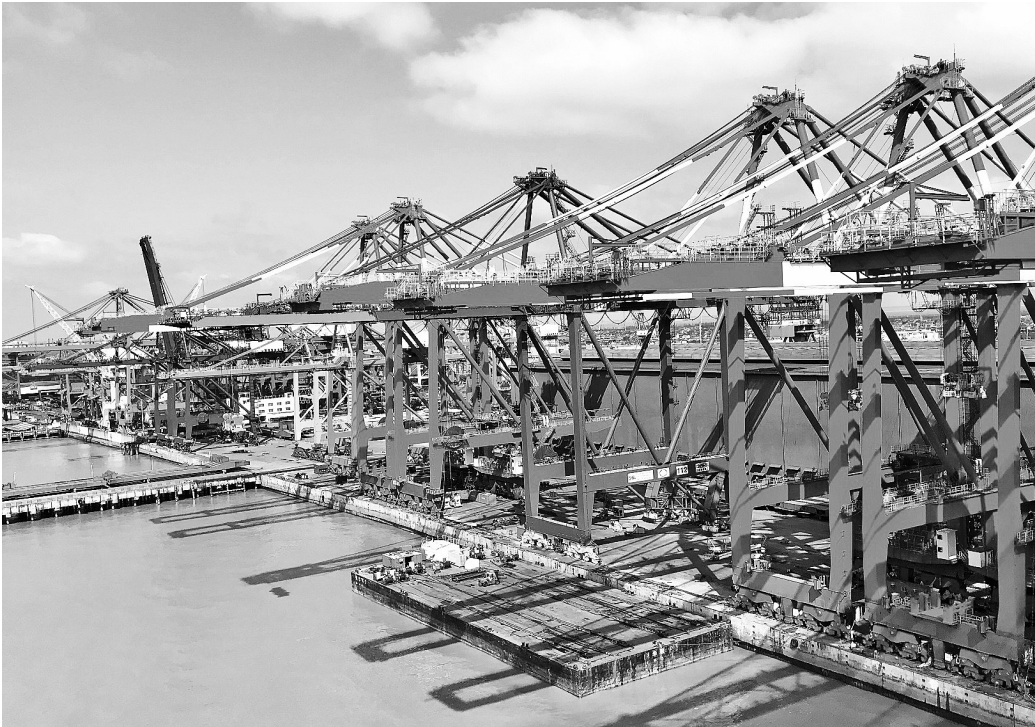
振华重工位于长兴的港机生产基地。 唐尧 摄
