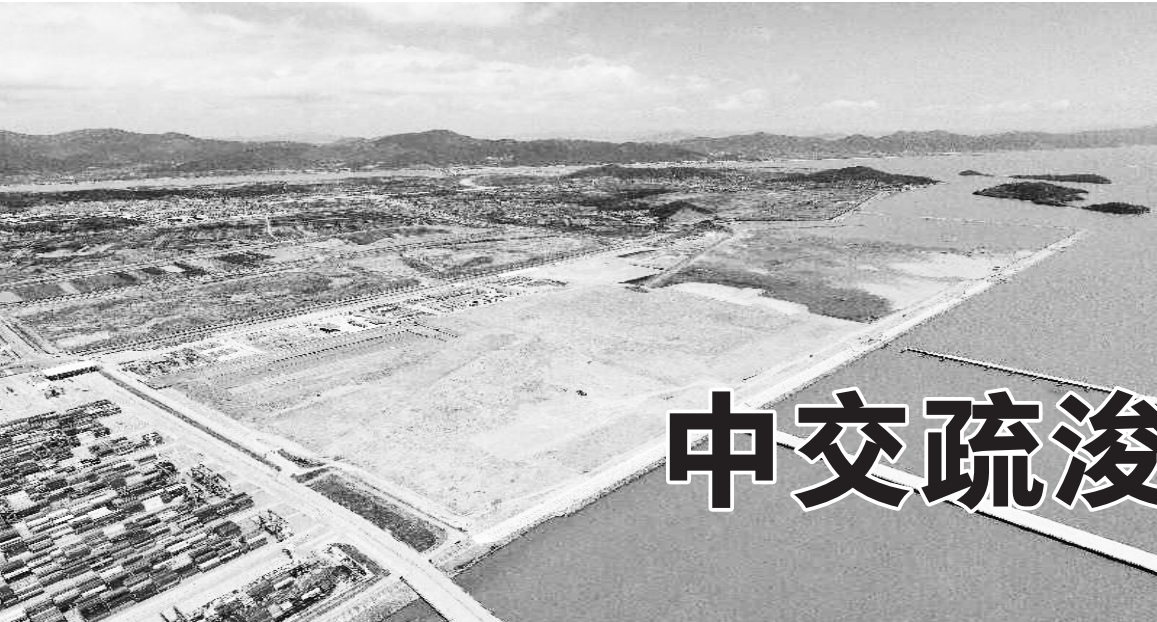
建设中的宁波舟山港梅山港区二期工程。
