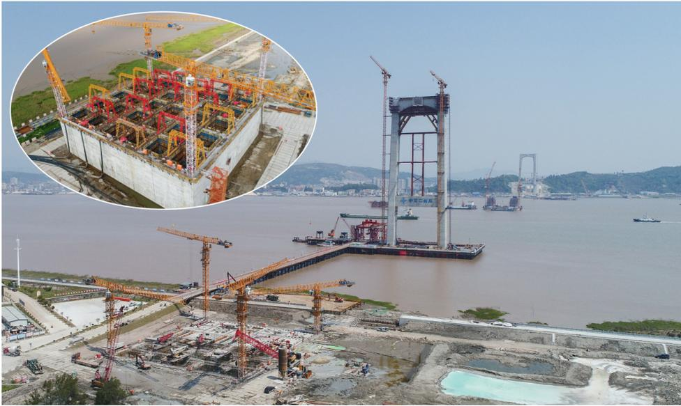
4月12日晚,随着最后一车填仓混凝土浇筑,中交二航局承建的温州瓯江北口大桥南锚沉井宣告施工完成,大桥建设取得突破性进展,这也是世界首个在深厚淤泥层中建造的超大型陆域沉井。
