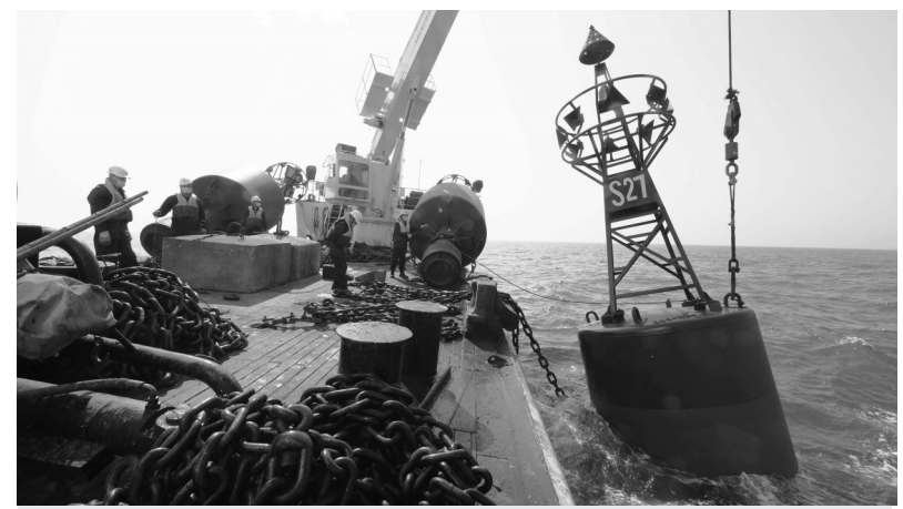
4月27日,青岛航标处对山东港口日照港石臼港区南作业区深水航道一期工程进行航标设置和调整,并在“五一”小长假期间加班加点布设航标。 杨柳 孙俊来 摄
