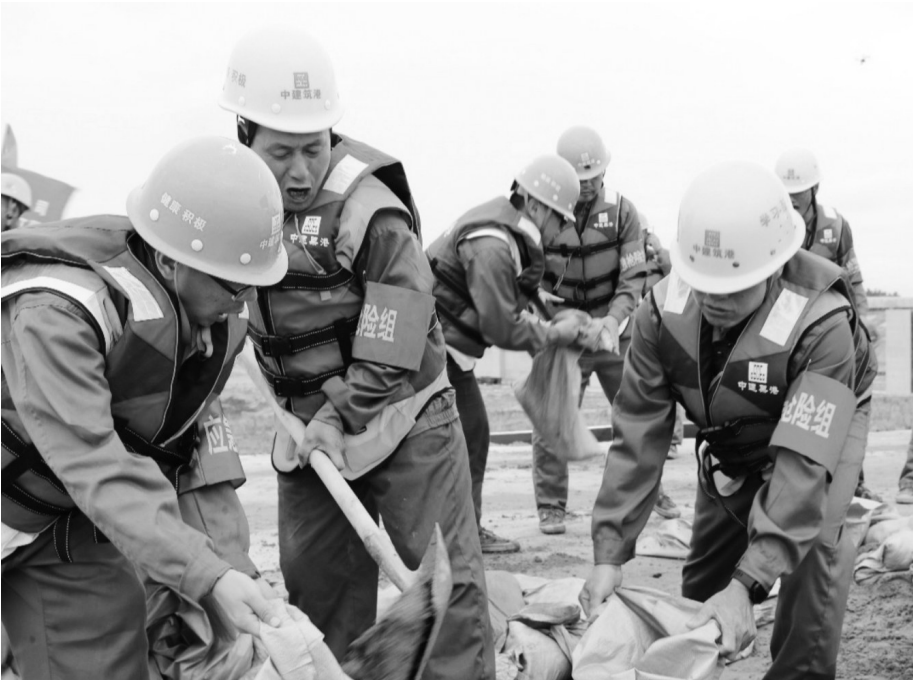
抢险人员正在装沙袋。 本报资料室供图
