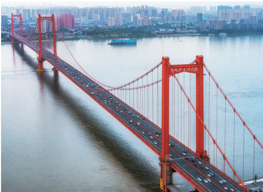
武汉鹦鹉洲长江大桥。
