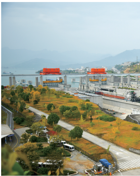
远眺三峡大坝五级船闸。
