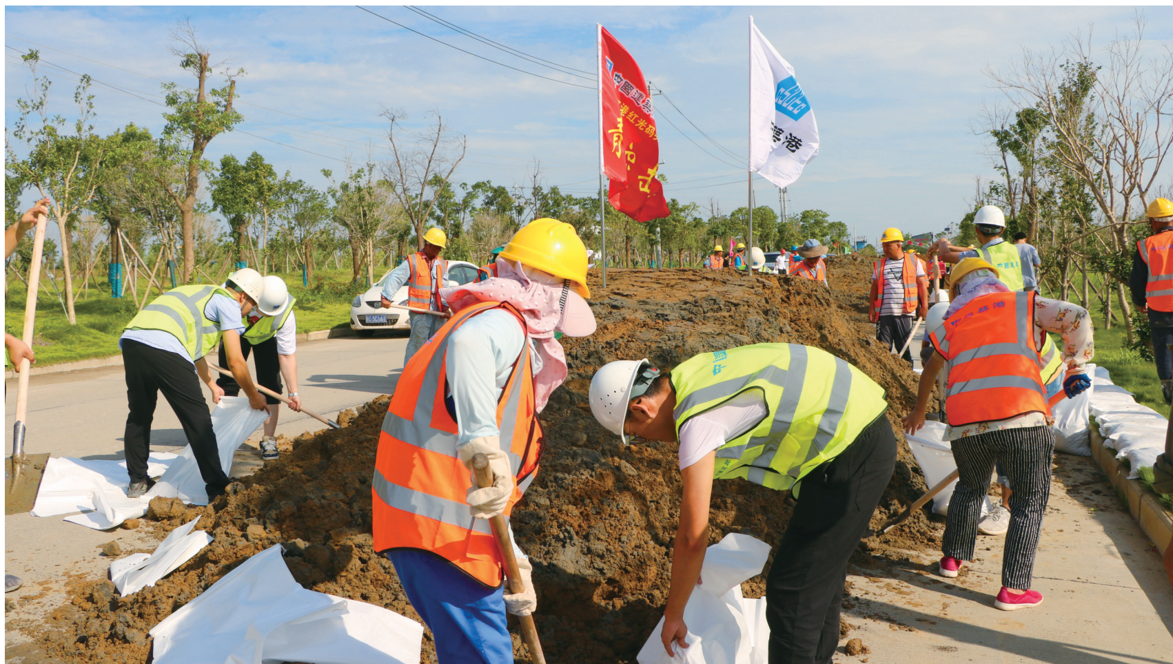
受持续强降雨和上游来水叠加影响,长江江西段水位迅速上升,防汛形势严峻。7月12日,中建筑港九江港红光码头项目部成立青年突击队,与其他参建单位组成防汛应急队,参与码头东侧红路筑堤工作。 郑潇 王昭君 摄
