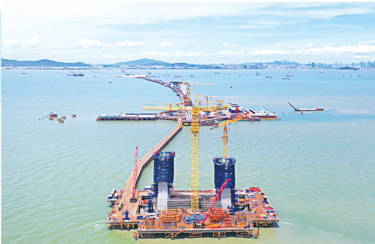
深中通道伶仃洋大桥海上施工平台。卢慧 摄
