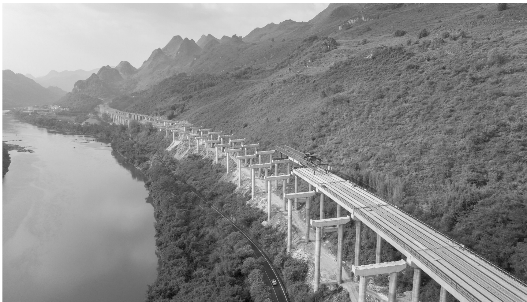
广连高速项目施工现场。
