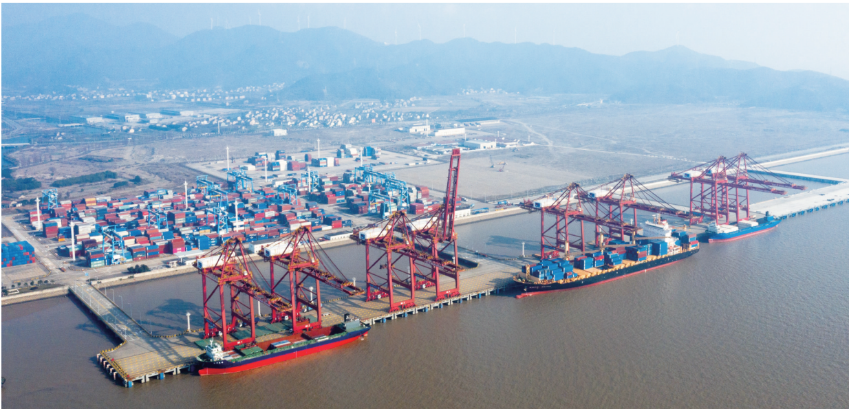
近日,宁波舟山港金塘港区大浦口集装箱码头工程二阶段3号泊位主体结构完工。宁波舟山港金塘大浦口集装箱码头工程是舟山口岸首个现代化国际集装箱码头。该工程规划建设2个10万吨级和3个7万吨级集装箱泊位(水工结构均按靠泊15万吨集装箱船设计),码头总长1774米,设计年吞吐量250万标准箱,总投资约64.3亿元。
