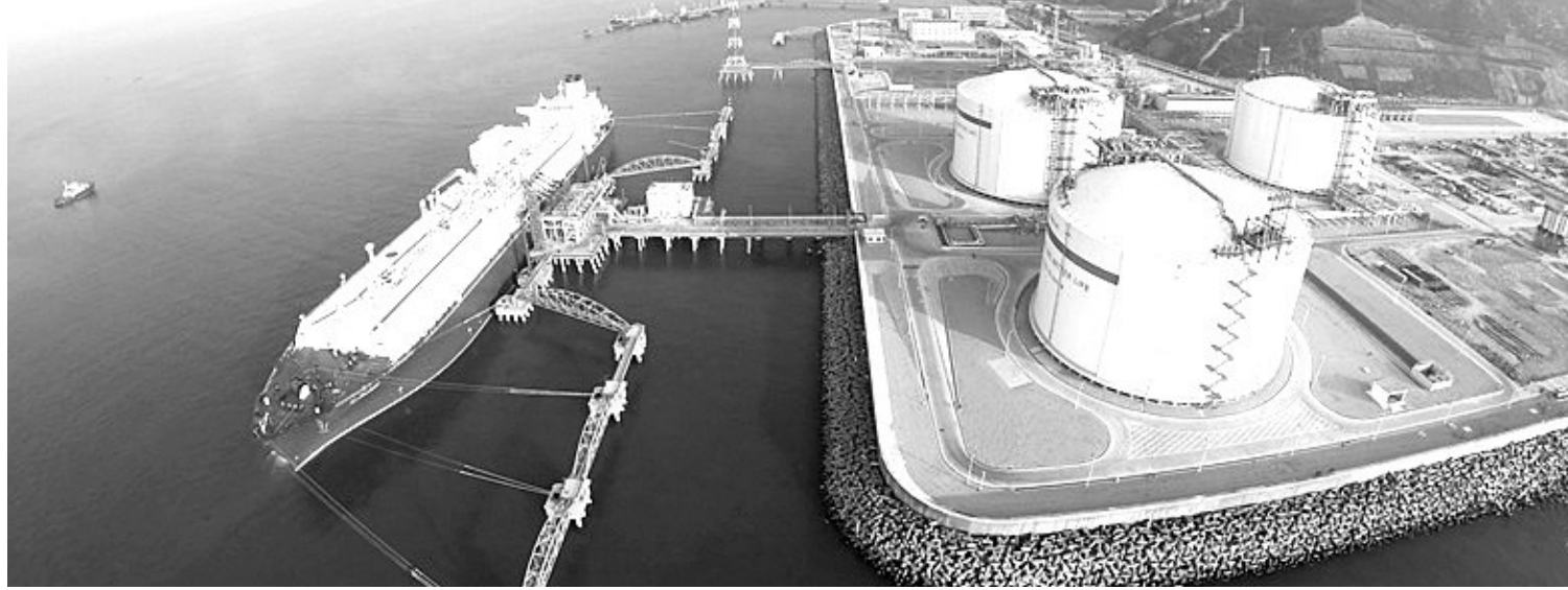
珠海 LNG 码头。 本报资料室供图
