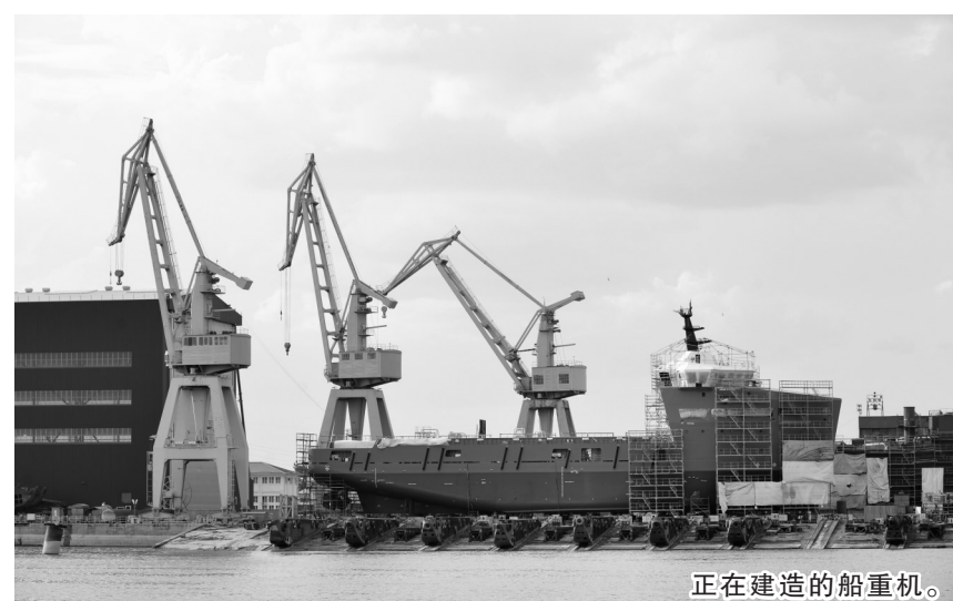
正在建造的船重机。
