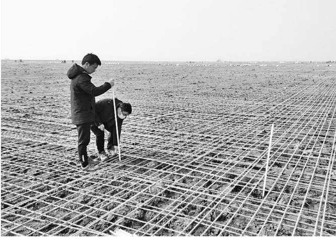
李明（左）在沙洲水道生态固滩工程现场布置固定监测点。 刘奇 摄
