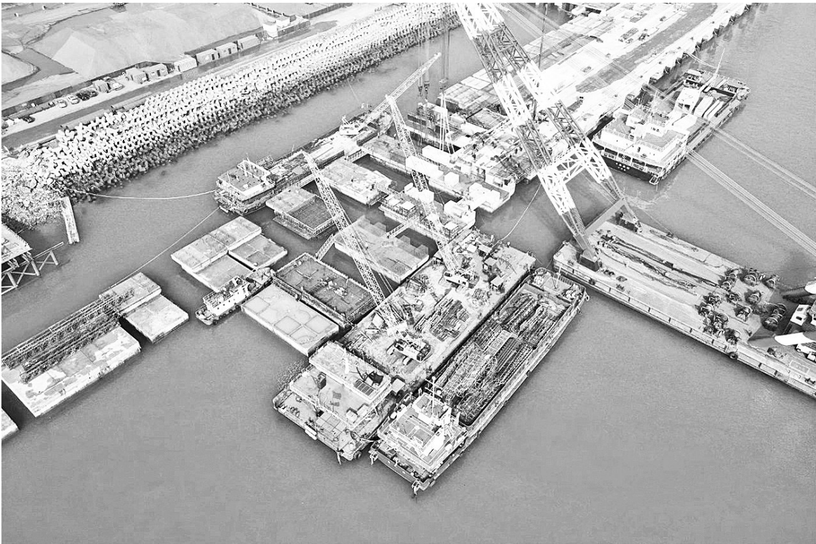
5月15日,山东港口日照岚岚山港区岚南#12泊位工程顺利通过竣工验收,该码头采用离岸式布置,主体由两排重力式沉箱墩结构和上部板梁结构组成,是沉箱墩和板梁结构在通用泊位上应用的首创。
