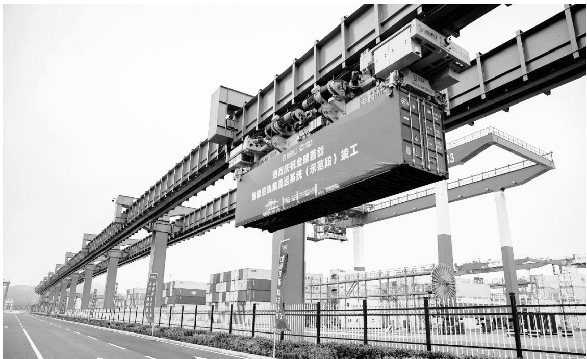
6月29日,山东港口全球首创智能空轨集疏运系统(示范段)竣工,该系统实现了空轨技术与港口业务的有机融合,打通了集装箱运输港、船、站、场间的“最后一公里”,构建起更加安全、高效、环保、经济的立体智慧绿色港口集疏运新模式样板,实现了港区交通由单一平面向立体互联的革命性突破升级。 杨柳 摄影报道
