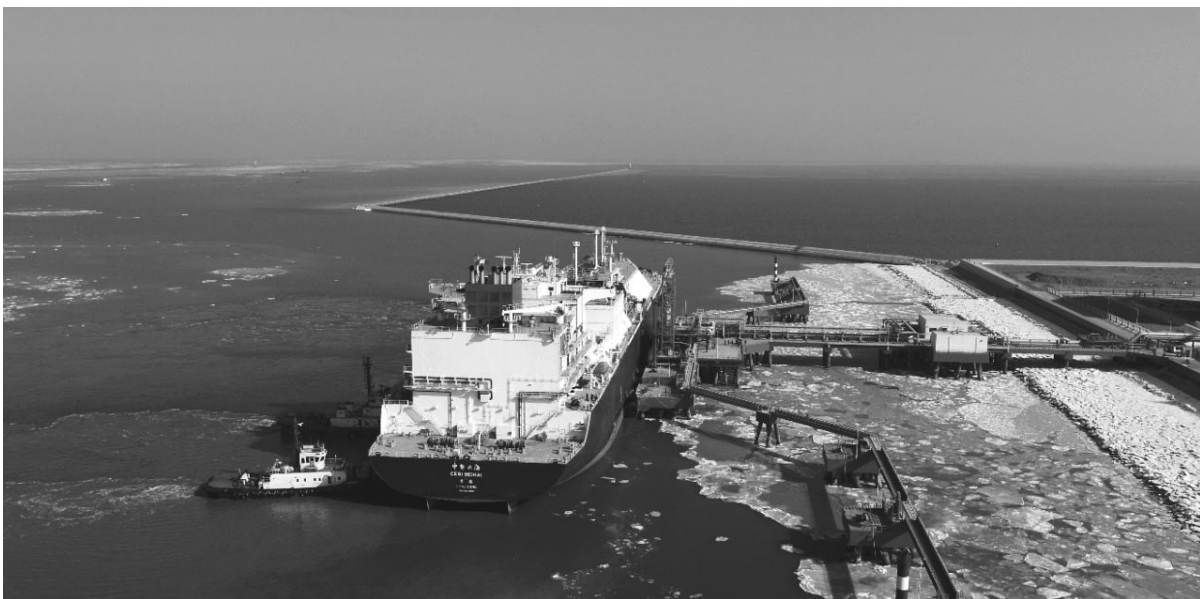
LNG船加注现场。图片由本报资料室提供
