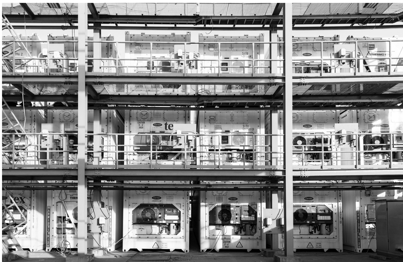
连云港冷藏集装箱堆场。本报资料室供图
